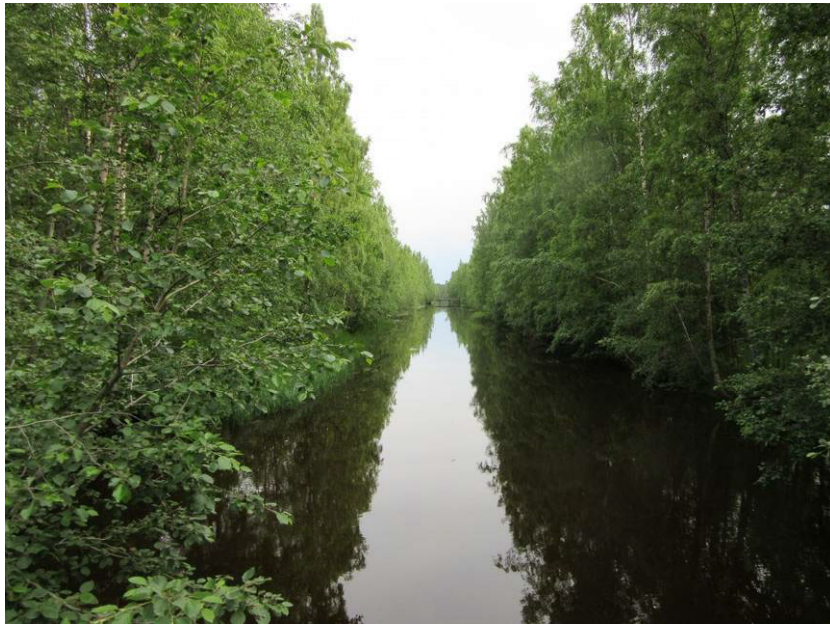
Kuljunlahden ja Piehinginjoen yhdistävä kanava kaivettiin 1960-luvulla, Raahen terästehdas saa jäähdytysvetensä joesta, kuva etelään.
